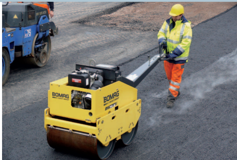
Exzellente Verdichtungsergebnisse auf Asphalt...
