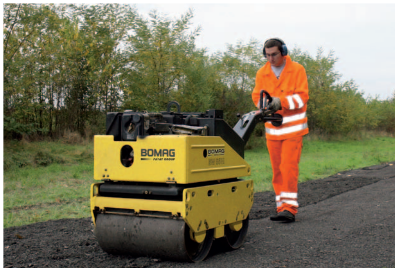
... und im Erdbau.
